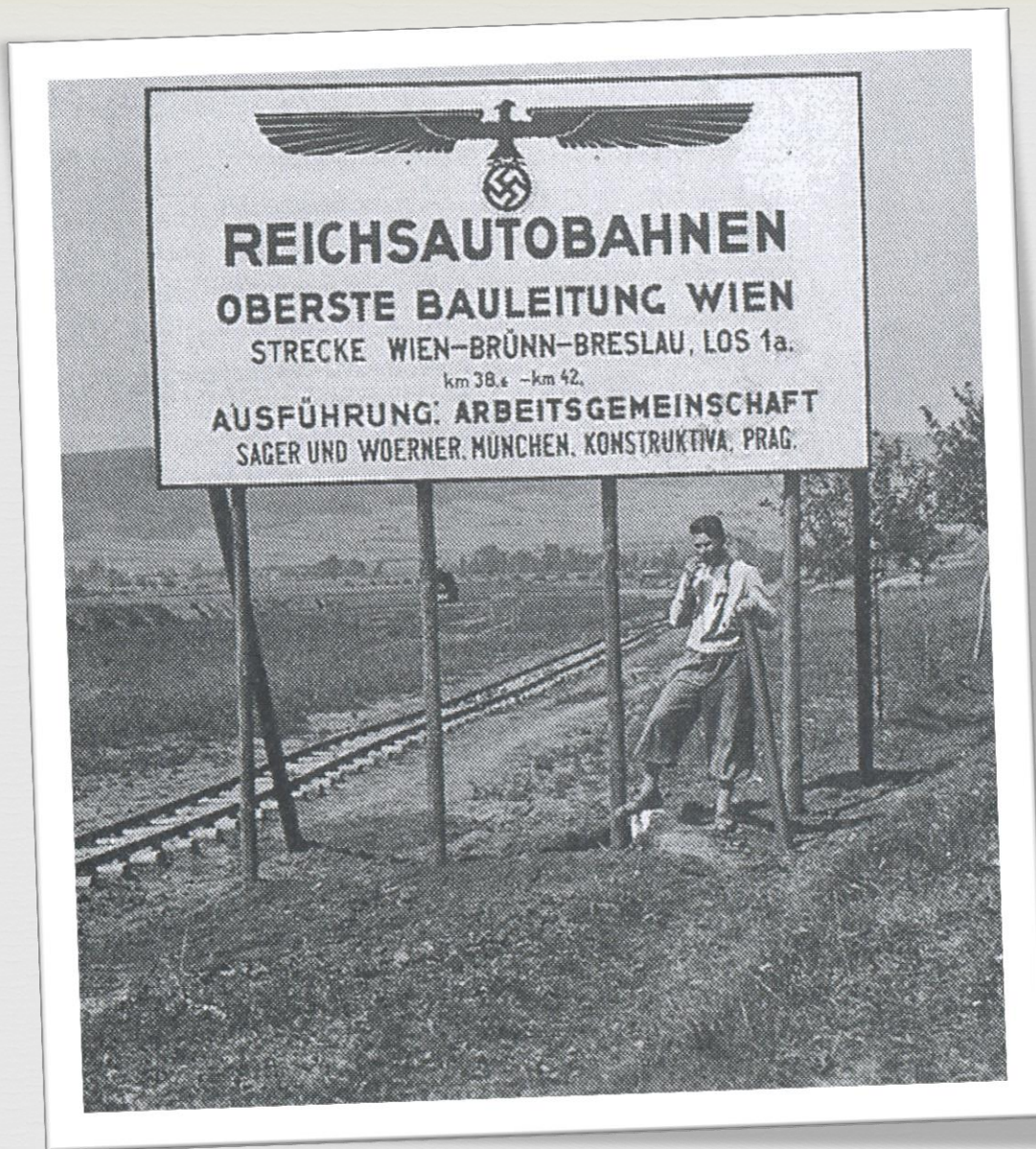
Informační tabule o stavbě dálnice
